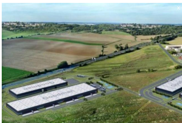
Figure 3 : Parc d'activité de la Goële – ZA de la Fontaine du Berger à Saint-Mard
